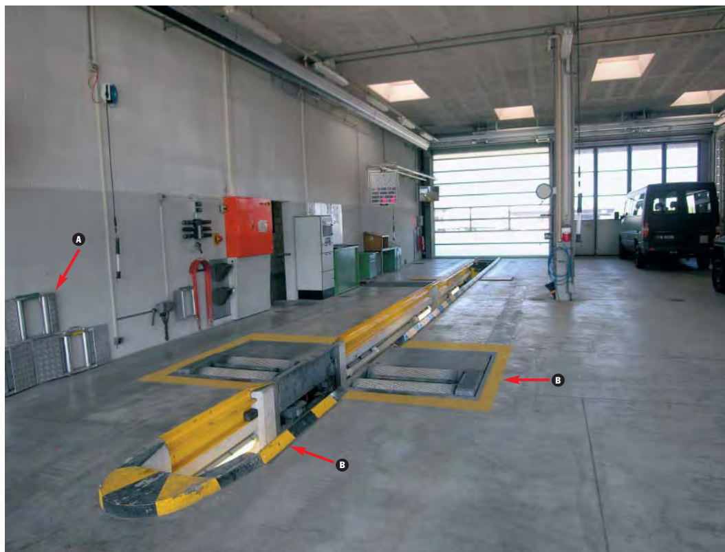
A Fissare e mettere in sicurezza gli oggetti. B Segnalare i punti pericolosi.
